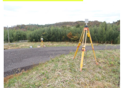
標定点設置状況
