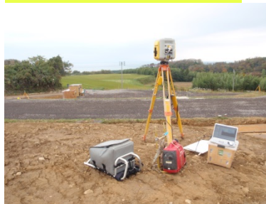
LSの設置状況
