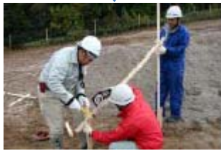
設計図に合わせ丁張り設置
