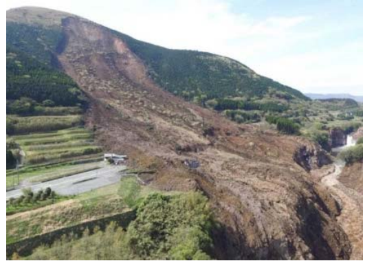
熊本県南阿蘇村土砂崩落現場 (出典:国土交通省 平成28年熊本地震による土砂災害の概要 H28.9.14)
