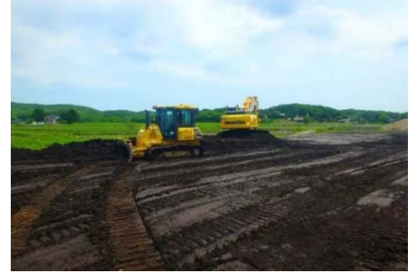
ICTブルドーザによる敷均 (6/7 撮影)
