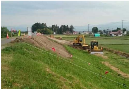
ICTバックホウによる表土剥ぎ取り (6/8 撮影)
