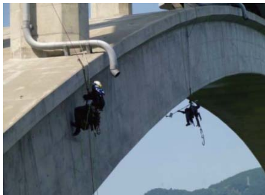
高所における橋梁の点検作業 (平成25年度 国土交通白書)
