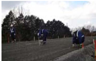
検測と施工を繰り返して整地
