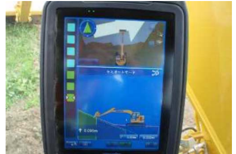
モニターによる施工状況の確認 (6/8 撮影)
