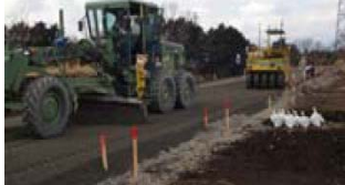
丁張りに合わせ施工
