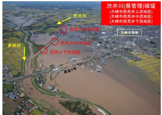
渋井川の決壊(宮城県) (出典:国土交通省 台風18号による大雨等に係る被害状況等について H27.9.15)
