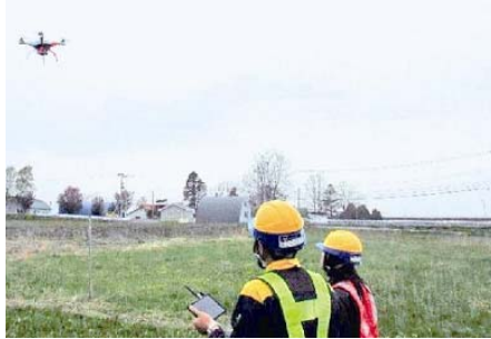
UAVによる施工前の測量 (5/10 撮影)
