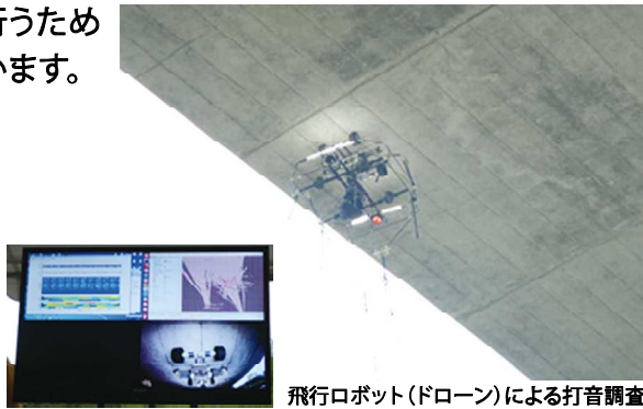
飛行ロボット(ドローン)による打音調査
