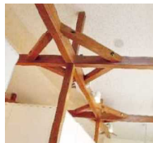
斜材による補強
