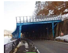
国道46号 生保内スノーシェッド
