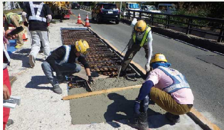
損傷部分を補修中
