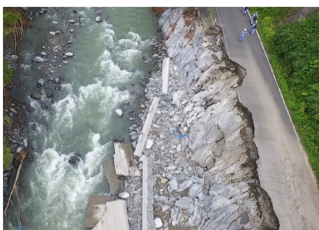
▲ ドローンを活用した被災状況調査
