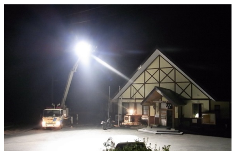
▲ 避難所への照明車設置
