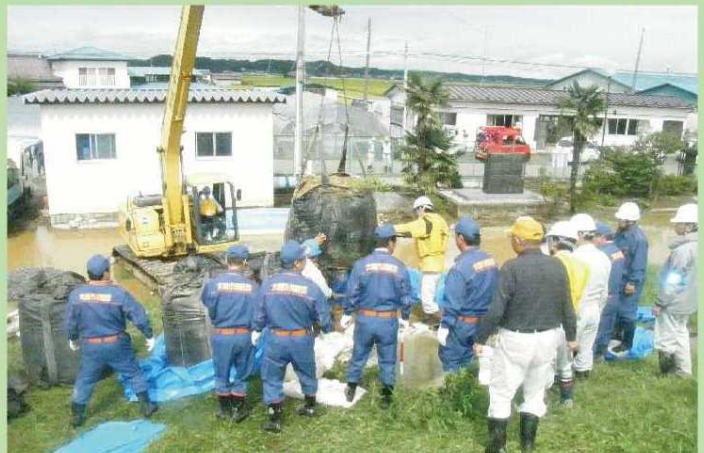
大型土のうを使用した月の輪工法実施の様子
