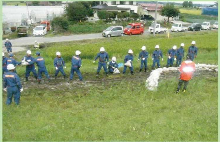
大崎市消防団による月の輪工法実施の様子
