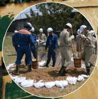
水防団(消防団)による水防工法訓練
