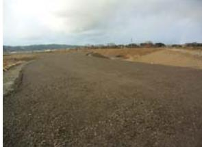
由利本荘市荒町地内において施工中でした盛土工事が完成しました。本工事は、荒町地区河川防災ステーション整備事業の一環として実施しており、今年度は管理用通路等の施工を行いました。今後は、ヘリポート、災害対策車等格納庫、水防用資材等の整備を行っていく予定です。整備完了後は、防災拠点エリアとして子吉川流域のみならず、県内及び隣県での大規模災害にも対応可能となります。
