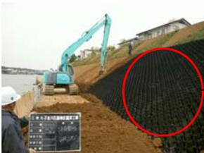
施工のポイントとしては、既設護岸上にそのまま覆土を実施しても土砂が滑り落ちることから、はじめに新技術の法面安定柁（ジオウエップ）を設置し、そのうえで覆土を実施しております。このことにより、土砂の滑り落ちを防ぎ、洪水により水位が上がった際に土砂が流出するのをある程度防ぐことが可能と考えております。
