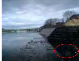
本荘市出戸町字浜ノ町地内に於いて施工中でした護岸工事がまもなく完成致します。H14.7の出水の際に被害があった箇所です。施工のポイントの一つとして、多孔性に富んだカゴマットを使用することにより、モクスガニや白魚等への影響も配慮した構造としました。
