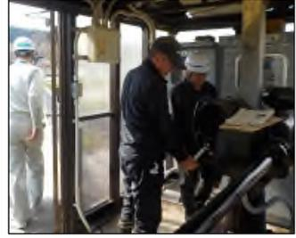
これから迎える本格的な出水期に備え、水門等水位観測員と職員が合同で、子吉川管内にある46箇所の樋門・樋管の点検を行いました。点検では、修繕が必要な箇所がないか、ゲート設備等に不具合がないか、洪水時に確実に作動できるか等を確認しました。補修が必要な箇所については、随時対応していく予定です。
