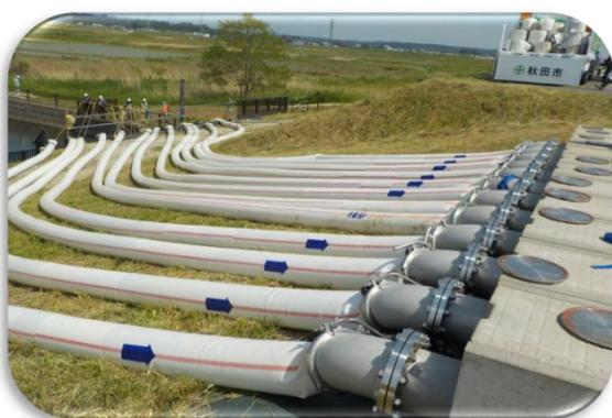
ホースが破損しないように養生をし、ねじれがないように布設していきます。
