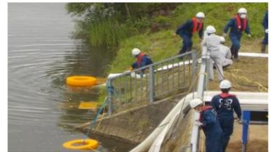
排水ポンプに係留ロープと浮き輪を取り付けポンプを投入。
