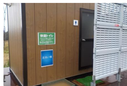
作業環境を良くするための快適トイレ (くつの泥を落とす洗い場も設けています)
