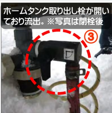
ホームタンク取り出し栓が開いており流出。※写真は閉栓後
