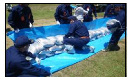
改良積土のう工
