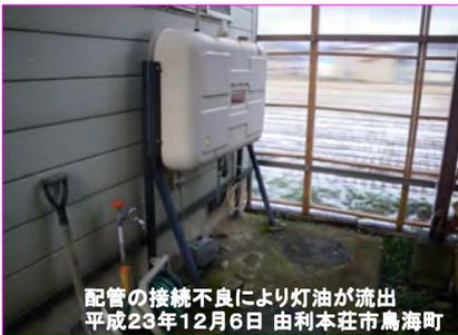
配管の接続不良により灯油が流出
