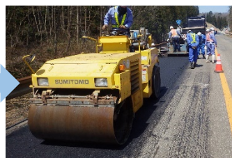
アスファルトを敷いて
