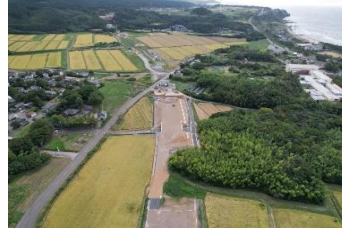
⑤大砂川地区道路改良工事 盛土 施工後 (象潟ICを背に小砂川IC(仮)方向を望む)
