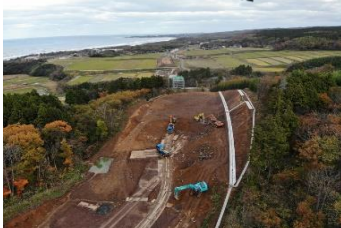
③堂ノ前地区道路改良工事 掘削 施工後 (小砂川IC(仮)を背に象潟IC方向を望む)
