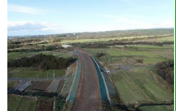
⑦大坂地区道路改良工事 盛土 施工後 (小砂川IC(仮)を背に象潟IC方向を望む)
