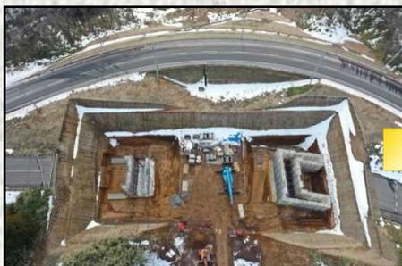
足場の施工後、鉄筋及び型枠の組立を行い、コンクリート打設に向けて作業中
