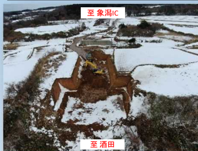
A2橋台の施工に先立ち、工事用道路と施工ヤードを整備しています。今年は、雪が多く、除雪しながらの作業となっています。
