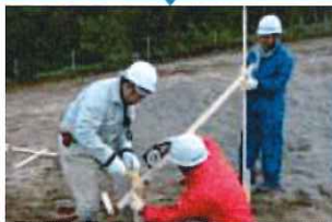
設計図に合わせ丁張り設置
