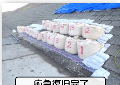
応急復旧完了
