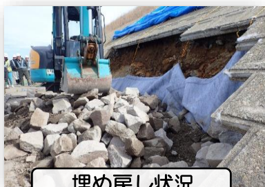
埋め戻し状況
