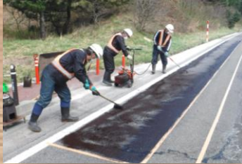
▲舗装の部分補修
