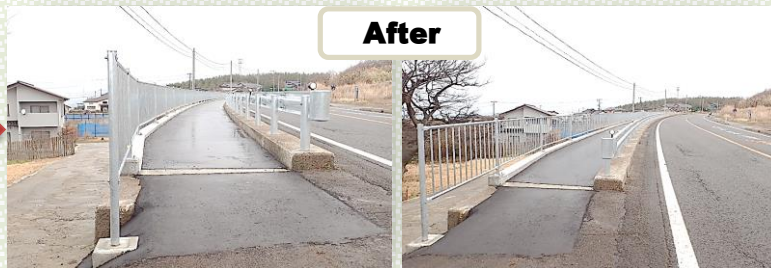
補修作業を行い、転落防止柵は潮風に強い仕様に変更しました
