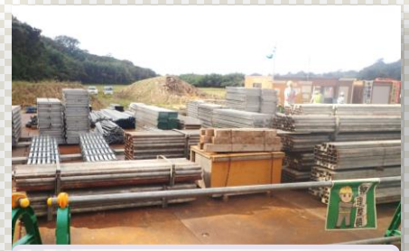
現場の整理整頓の状況も確認
