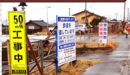
わかりやすい工事看板を心がけて
