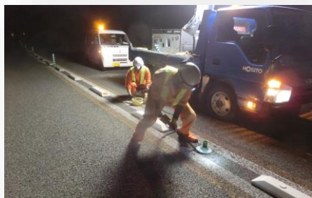
▲道路付属物の補修
