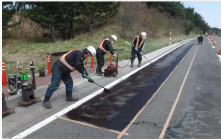
▲舗装の部分補修
