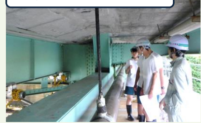
構造物の内部を見学
