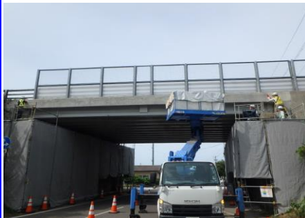
橋のひび割れを確認します。
