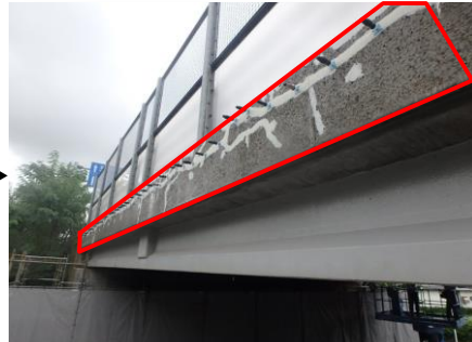
ひび割れ内部に補修材を注入します。
