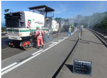
いたんだ舗装を剥ぎ取ります。
