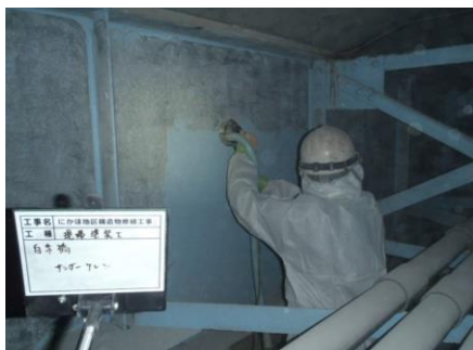
古くなった塗装を剥ぎ取ります。
