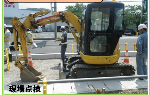
国道7号の歩道工事
