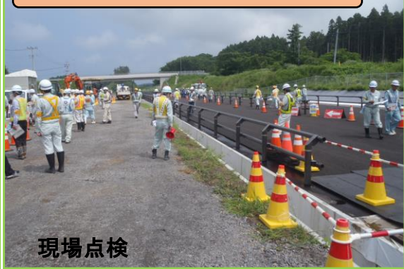
象潟仁賀保道路の道路付属物工事
