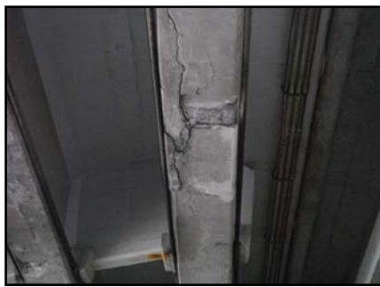
塩風や融雪剤の影響でコンクリートのひび割れや鋼材の錆が進行
