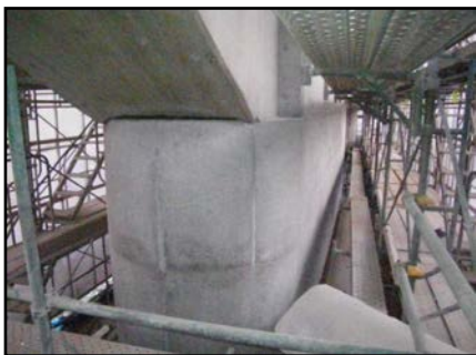
①下部工の補強状況
