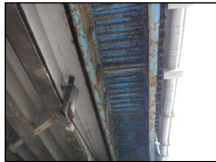
塩風や融雪剤の影響でコンクリートのひび割れや鋼材の錆が進行
