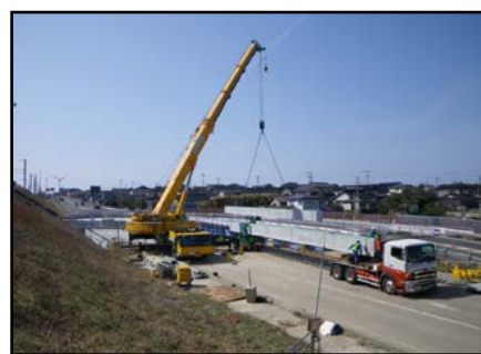
②橋桁を架けている状況
