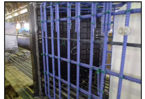
樹脂塗料で被覆した錆びにくい鉄筋を使用
