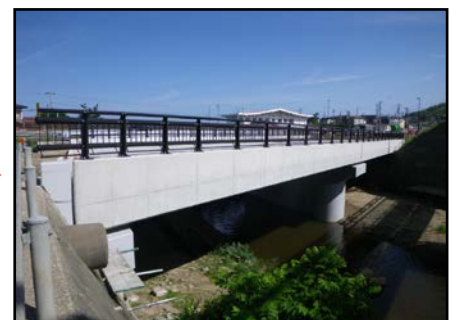
③上部工完成
