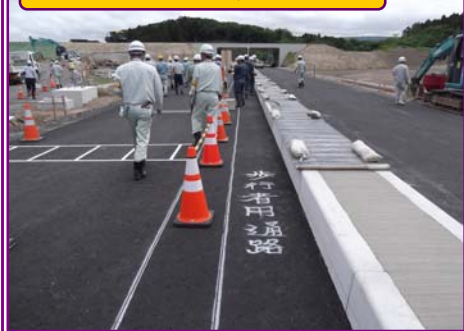
金浦道路改良舗装工事現場
