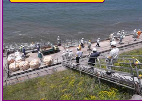
本荘国道法面工事現場
