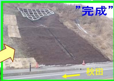
<国道7号:芦川地区法面> 写真:由利本荘市芦川地区(上り線)
