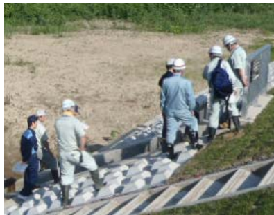
H24工事箇所の説明
