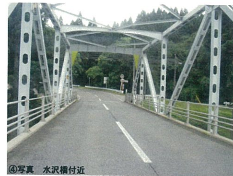
④写真 水沢橋付近
