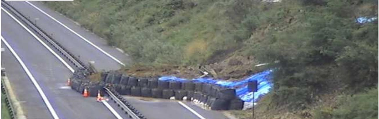
現在、崩落した法面から湧水が続いており、二次災害の恐れがあるため応急復旧作業ができないことから通行止めを継続します。
