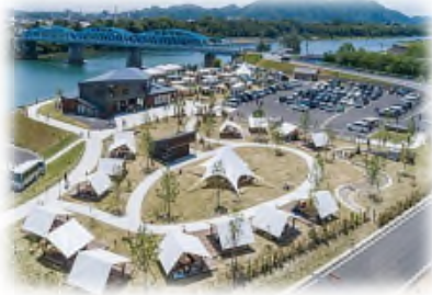
賑わい拠点の整備 (木曾川/美濃加茂市)
