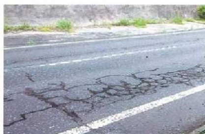
舗装損傷の例
