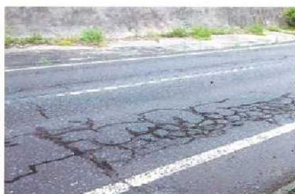
舗装損傷の例
