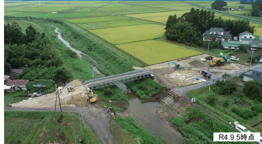
市道窪川原線 丸山橋 応急組立橋 架設状況
