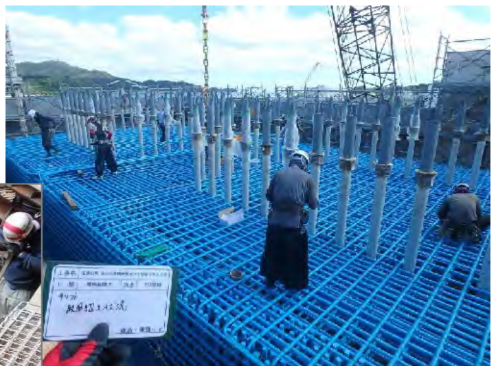
▲鉄筋組立作業 (エポキシ樹脂塗装鉄筋)
