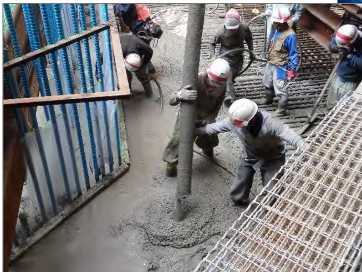
▼コンクリートを流し込む様子
