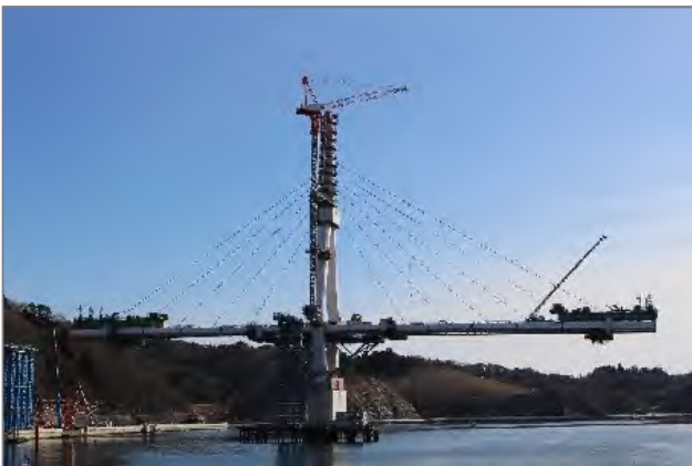
▲ バランシング架設
