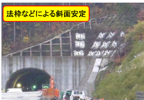
▲坑口斜面の対策例
