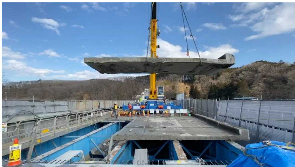
既設床版の撤去状況
