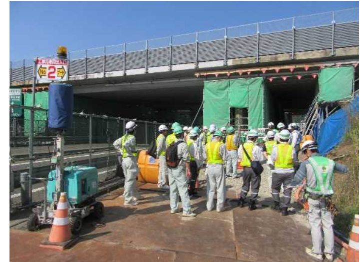
令和元年 東北自動車道仙台南IC橋現場見学会の様子
