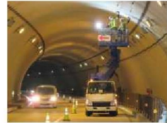
トンネル点検
