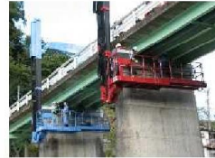
橋梁点検 (点検車)
