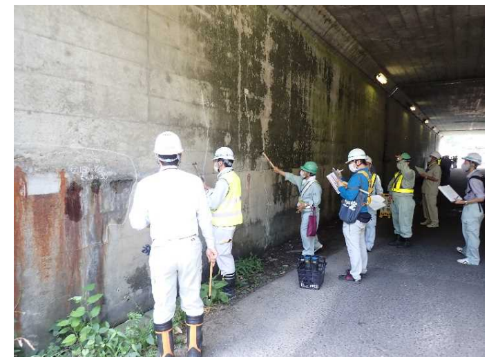
▲令和3年度 溝橋講習会の様子（国道48号西-14ボックス）
