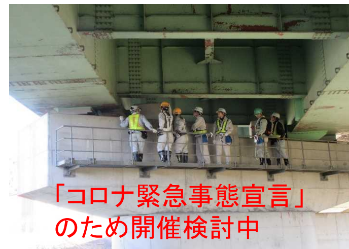
▲平成30年度 橋梁点検講習会の様子 (国道45号古川橋)
