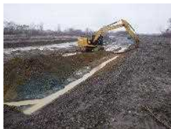
河道掘削 (石狩川水系、北海道開発局)
