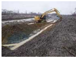
河道掘削 (石狩川水系、北海道開発局)
