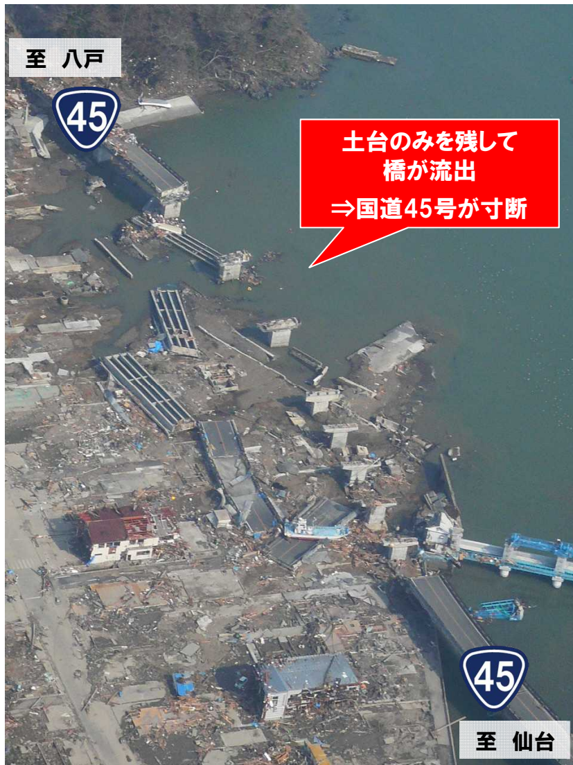
[東日本大震災時の被害状況(国道45号歌津大橋)]
