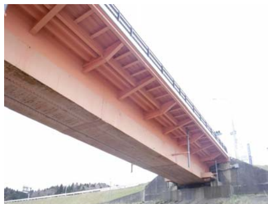
写真4-3 【対策】 床版取替、防護柵取替等
