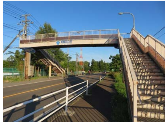
写真4-19 【全景】白沢横断歩道橋
