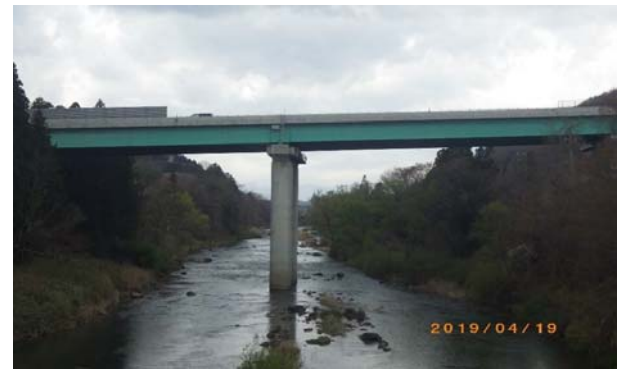
写真4-16 【全景】広瀬川橋
