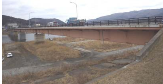
写真4-1 【全景】新飯野川橋
