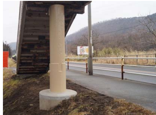
写真4-21 【対策】当て板補修
