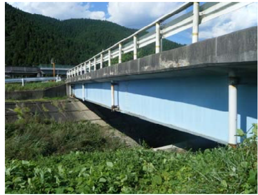
写真4-13 【全景】新北沢橋
