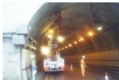
写真2-2 トンネル点検状況
