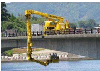
写真2-1 橋梁点検状況
