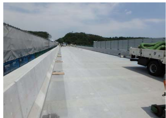
写真4-18 【対策】床版取替
