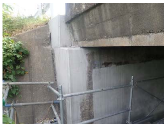
写真4-6 【対策】断面修復
