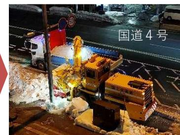
②ロー刈-除雪車でダンプトラックに積み込み
