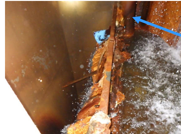
雨水吐口内堆積物 除去前 代表箇所
