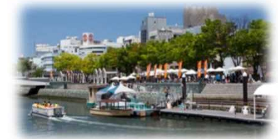
親水護岸の利用 (新町川／徳島市)
