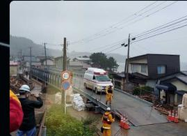
応急組立橋は、災害による落橋、道路崩壊等時に、仮の道路機能復旧用として使用します。橋長は、最小10m～最大40mの長さを確保できます。
