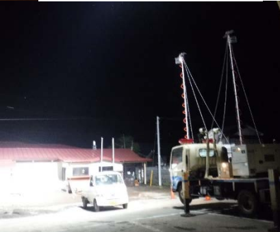
岩泉町 安家地内 岩泉役場安家支所
