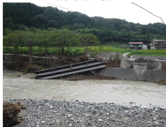
岩泉町 橋の下地内
