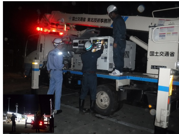
照明車設営指導 稼働報告
