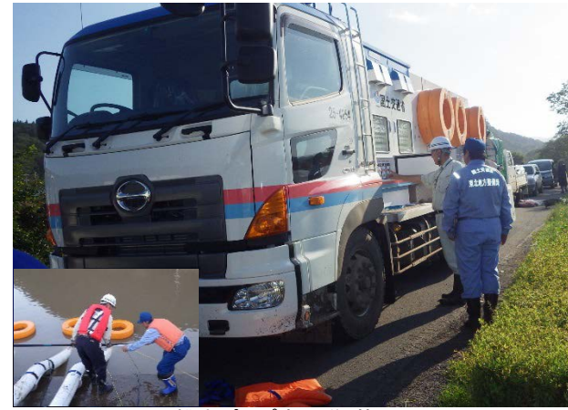
排水ポンプ車設営・管理
