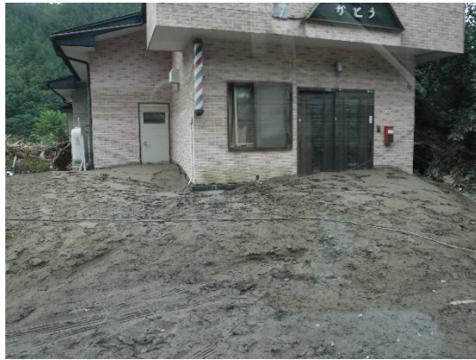
岩泉町 乙茂上地内
