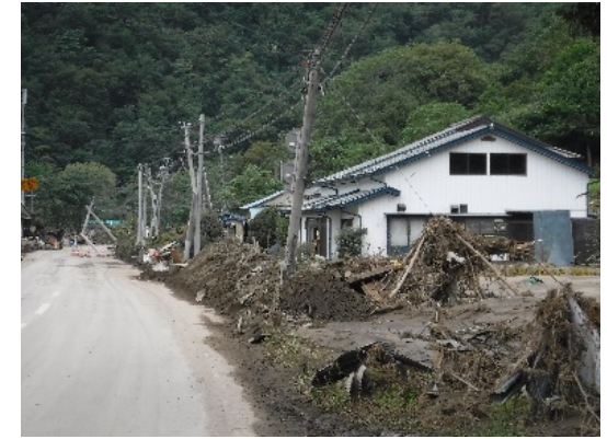
岩泉町 乙茂上地内
