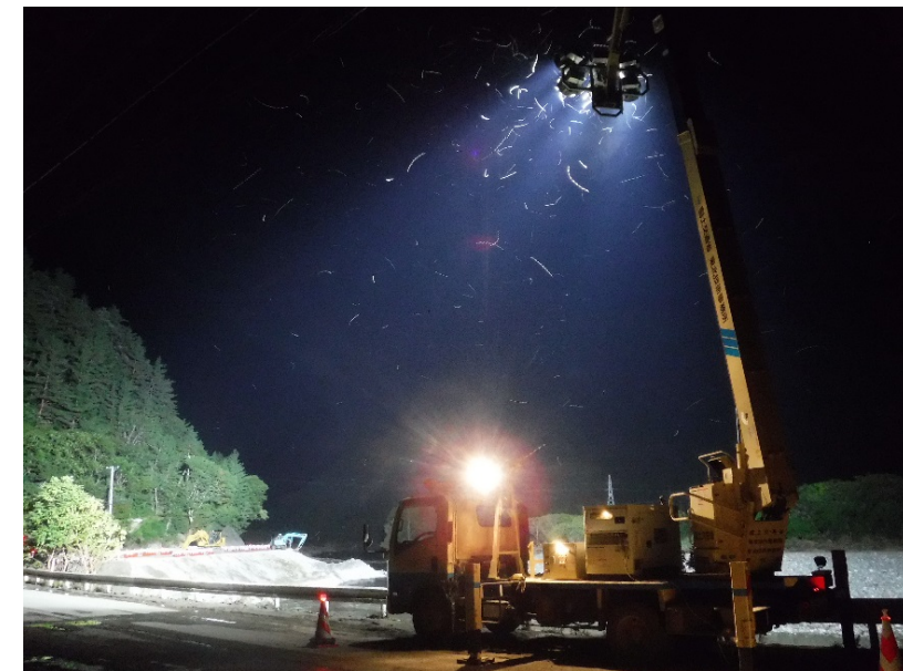
岩泉町 乙茂地内 国道455号復旧工事
