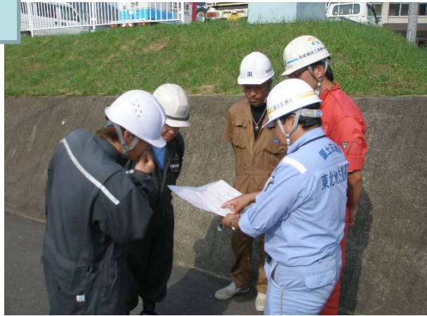
災害対策機械設営箇所指示
